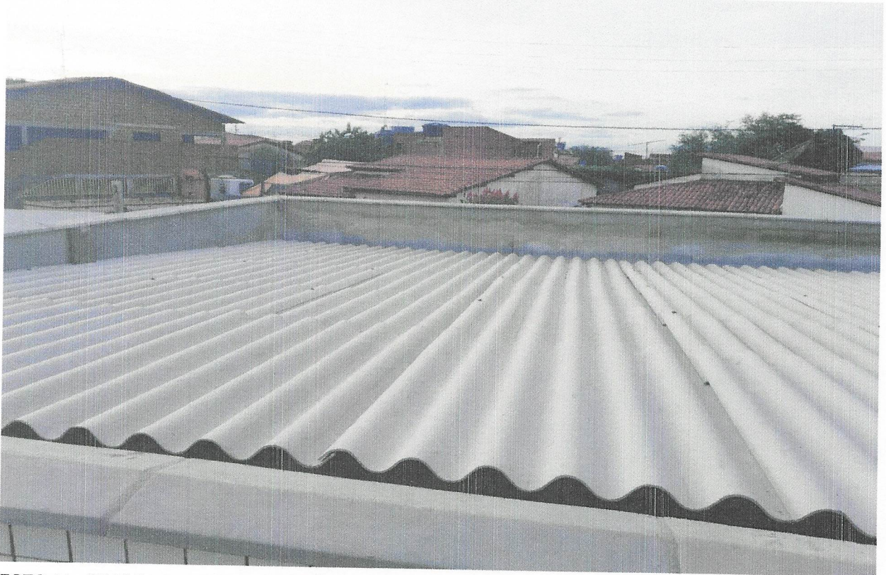
FOTO 14 - ÇAPIM DE CONCRETO PRÉ-MOLDADO
