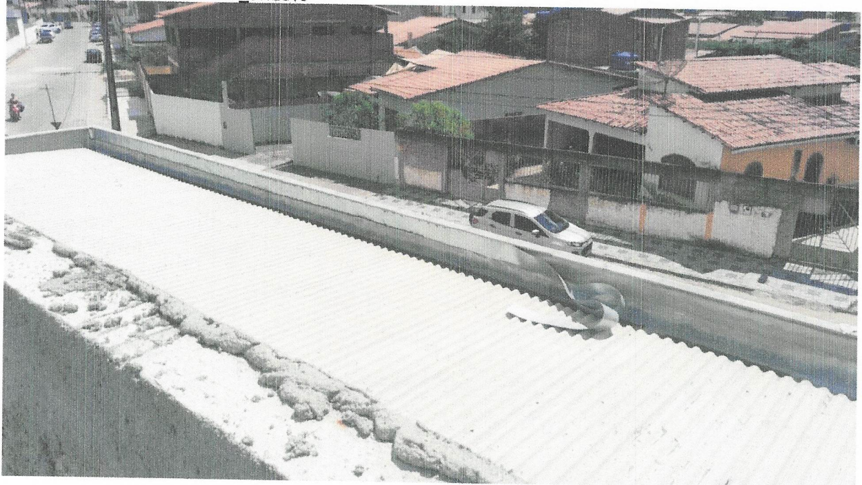
FOTO 51 - RUFO EM CHAPA DE AÇO GALVANIZADO NÚMERO 24, CORTE DE 25 CM, INCLUSO TRANSPORTE VERTICAL. AF_07/2019
