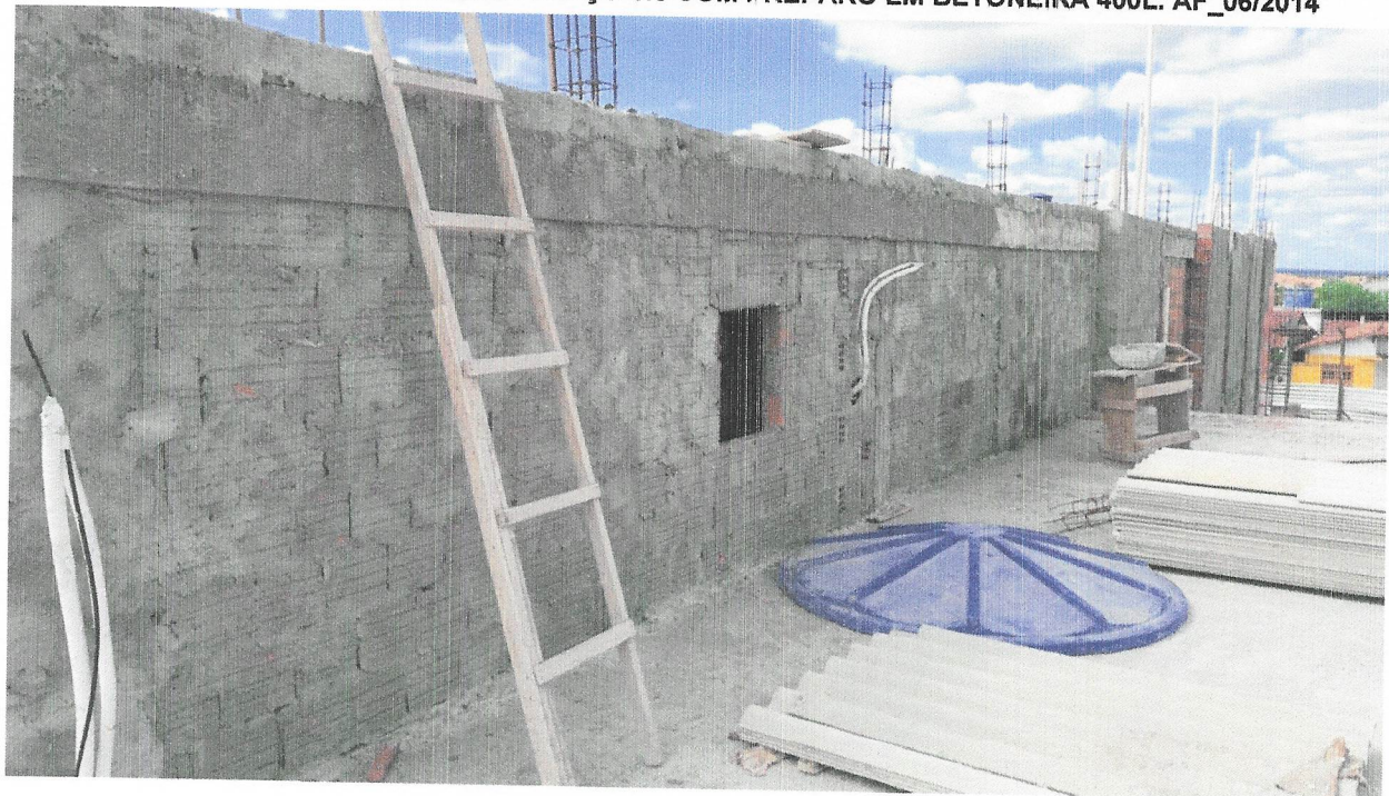
FOTO 10 - CHAPISCO APLICADO EM ALVENARIAS E ESTRUTURAS DE CONCRETO INTERNAS, COM COLHER DE PEDREIRO. ARGAMASSA TRAÇO 1:3 COM PREPARO EM BETONEIRA 400L. AF_06/2014
