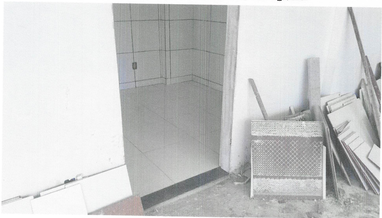
FOTO 29 - $OLEIRA EM GRANITO, LARGURA 15 CM, ESPESSURA 2,0 CM. AF_09/2020
