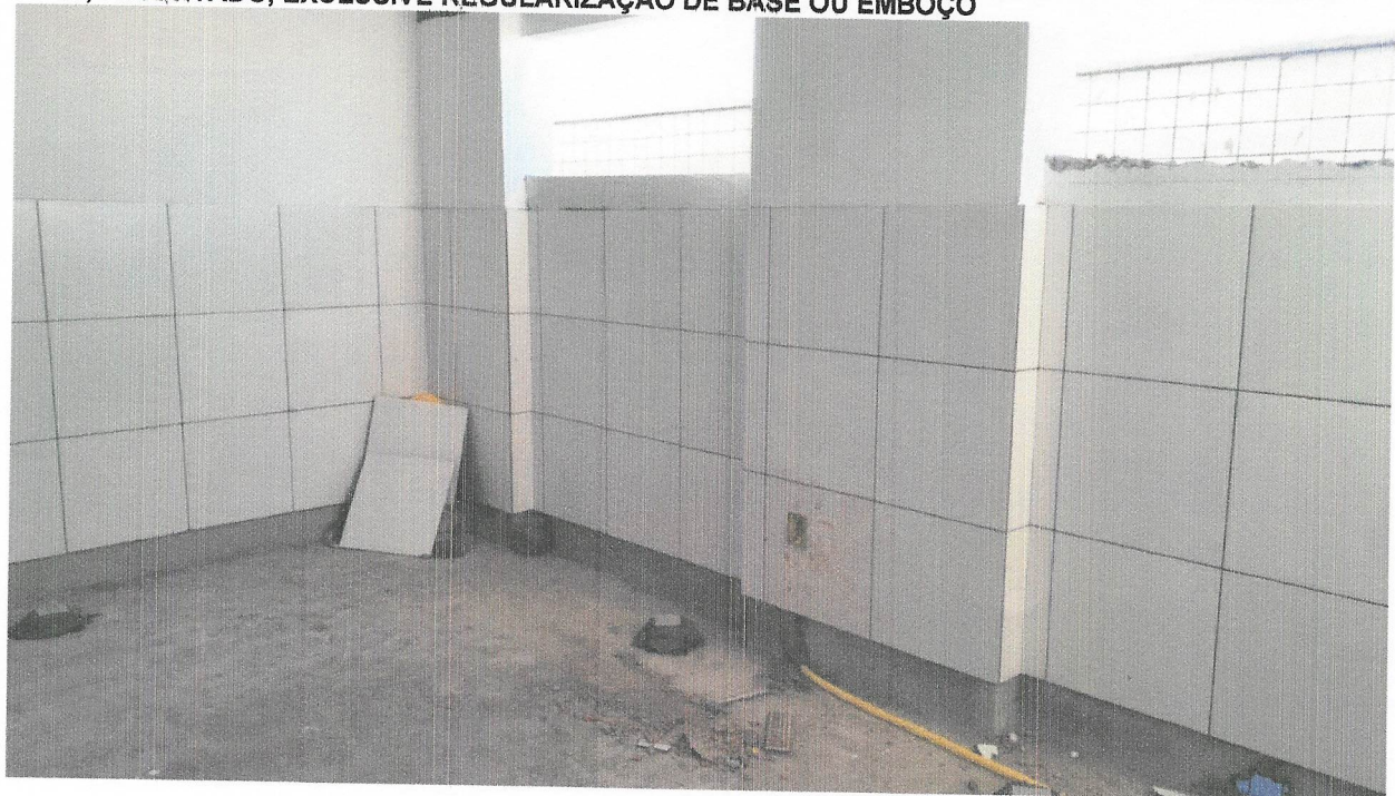
FOTO 24 - REVESTIMENTO CERÂMICO PARA PISO OU PAREDE, 60 X 60 CM, C/ PISO PORCELANATO URBANUS NATURAL RET, INCEPA OU SIMILAR, PEI 5, APLICADO COM ARGAMASSA INDUSTRIALIZADA AC-III, REJUNTADO, EXCLUSIVE REGULARIZAÇÃO DE BASE OU EMBOÇO
