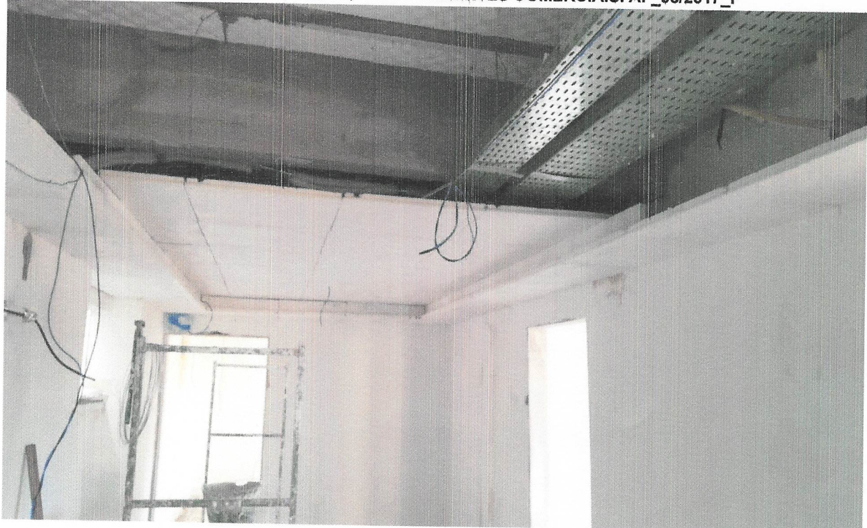
FOTO 31 - FORRO EM PLACAS DE GESSO, PARA AMBIENTES COMERCIAIS. AF_05/2017_P
