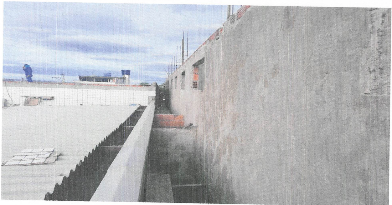
FOTO 14 - ÇAPIM DE CONCRETO PRÉ-MOLDADO
