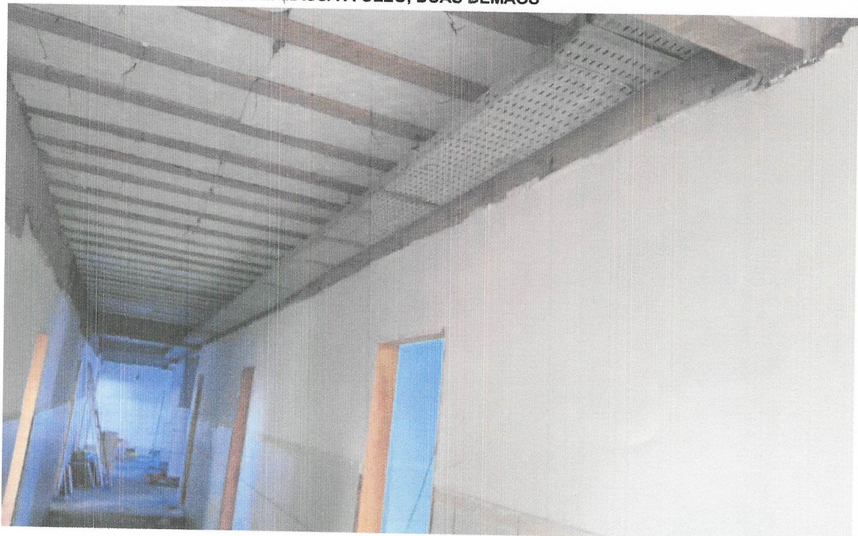
FOTO 37 - EMASSAMENTO COM MASSA A OLEO, DUAS DEMAOS
