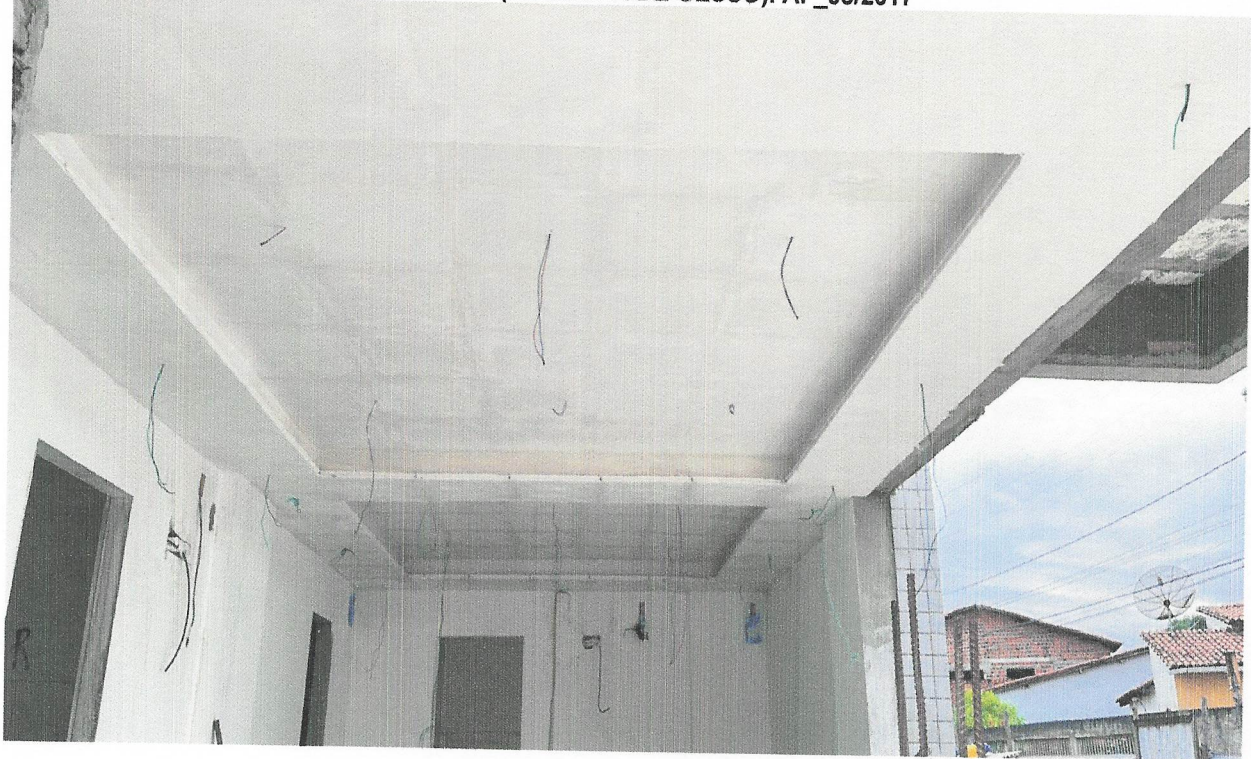
FOTO 33 - APLICAÇÃO DE FUNDO SELADOR ACRÍLICO EM PAREDES, UMA DEMÃO. AF_06/2014
