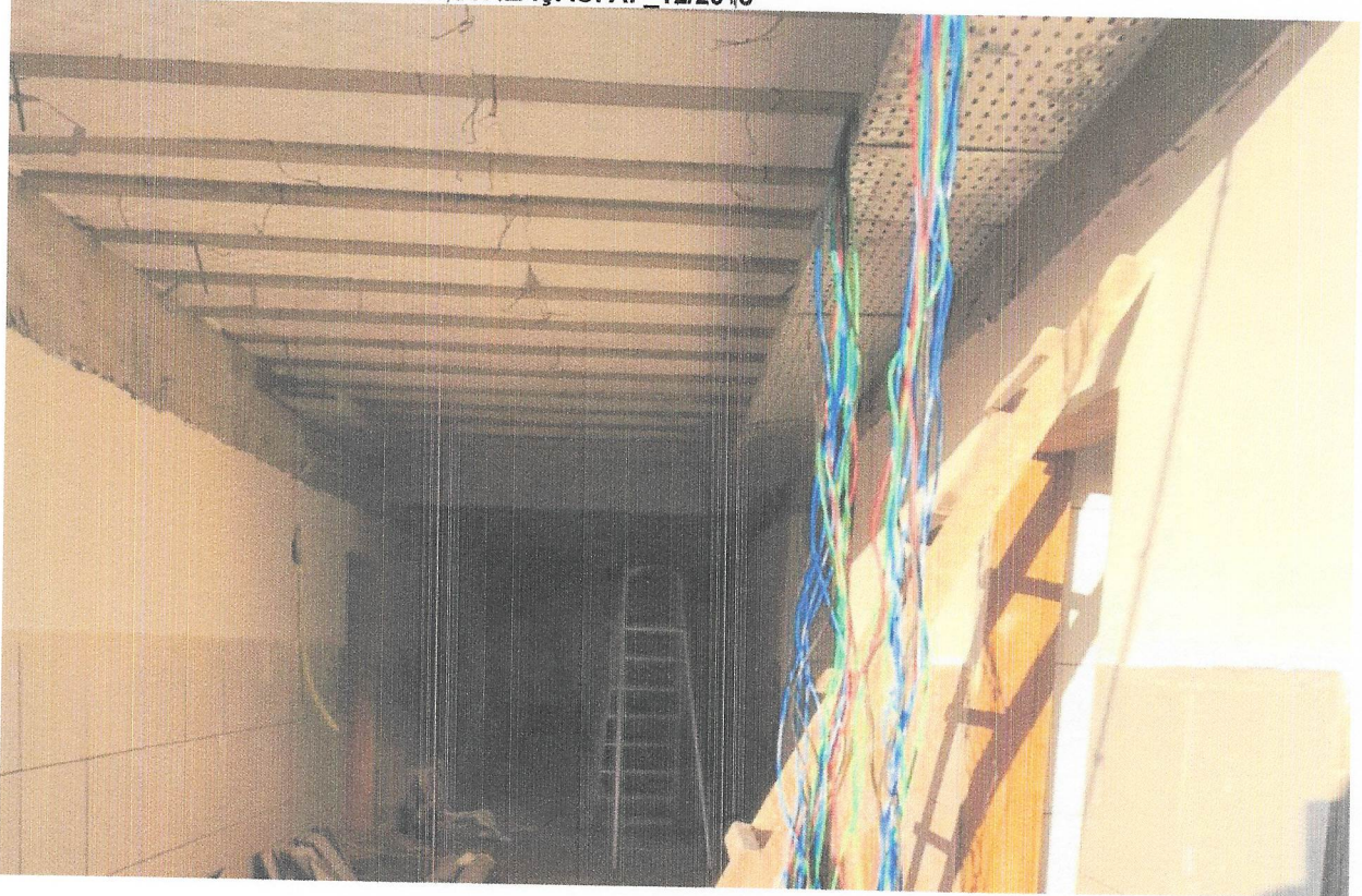
FOTO 69 – CABO DE COBRE FLEXÍVEL ISOLADO, 4 MM 2 , ANTI-CHAMA 450/750 V, PARA CIRCUITOS TERMINAIS - FORNECIMENTO E INSTALAÇÃO. AF_12/2015
