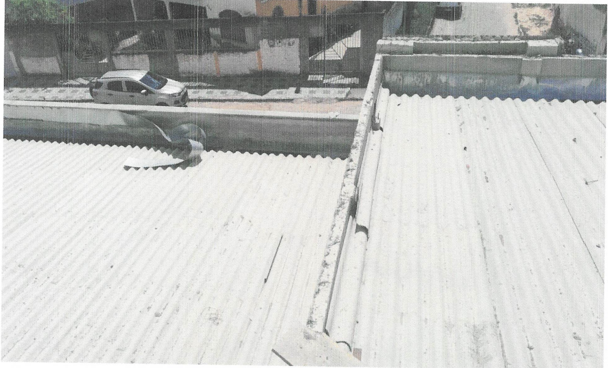
FOTO 53 – TELHAMENTO COM TELHA ONDULADA DE FIBROCIMENTO E = 6 MM, COM RECOBRIMENTO LATERAL DE 1 1/4 DE ONDA PARA TELHADO COM INCLINAÇÃO MÁXIMA DE 10°, COM ATÉ 2 ÁGUAS, INCLUSO IÇAMENTO. AF_07/2019
