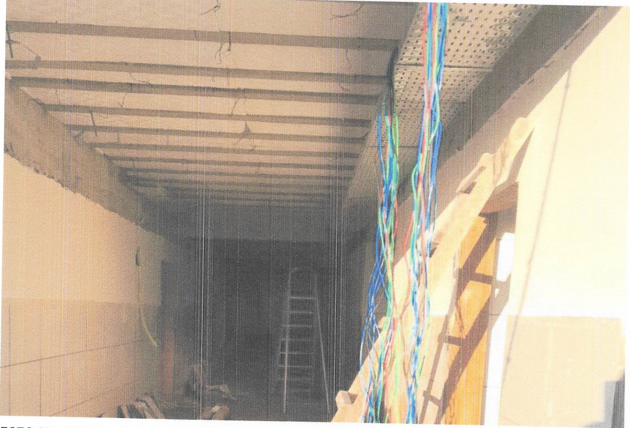
FOTO 67 – CABO DE COBRE FLEXÍVEL ISOLADO, 2,5 MM 2 , ANTI-CHAMA 450/750 V, PARA CIRCUITOS TERMINAIS - FORNECIMENTO E INSTALAÇÃO. AF_12/2015
