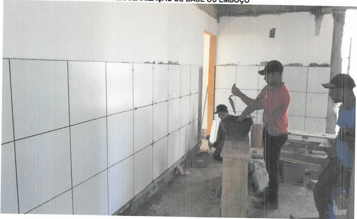
FOTO 24 - REVESTIMENTO CERÂMICO PARA PISO OU PAREDE, 60 X 60 CM, C/ PISO PORCELANATO URBANUS NATURAL RET, INCEPA OU SIMILAR, PEI 5, APLICADO COM ARGAMASSA INDUSTRIALIZADA AC-III, REJUNTADO, EXCLUSIVE REGULARIZAÇÃO DE BASE OU EMBOÇO
