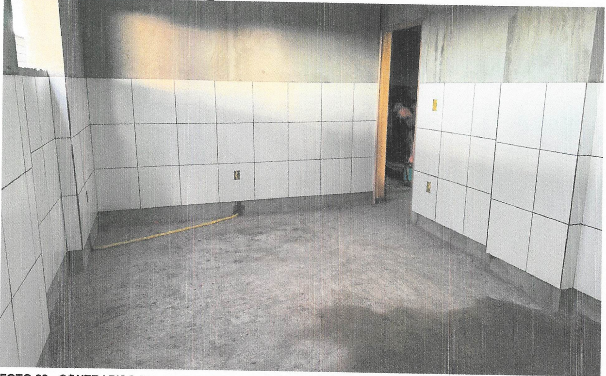
FOTO 22 - CONTRAPISO EM ARGAMASSA TRAÇO 1:4 (CIMENTO E AREIA), PREPARO MECÂNICO COM BETONEIRA 400 L, APLICADO EM ÁREAS SECAS SOBRE LAJE, ADERIDO, ACABAMENTO NÃO REFORÇADO, ESPESSURA 3CM. AF_07/2021
