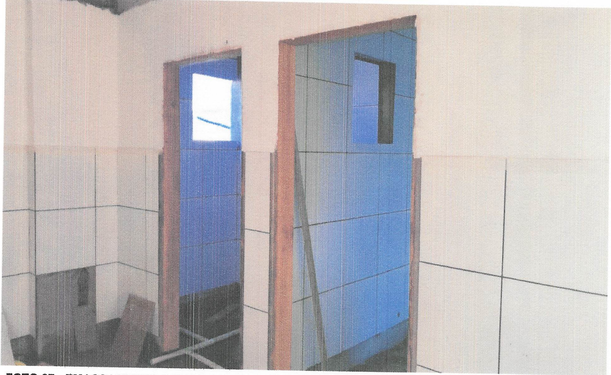
FOTO 37 - EMASSAMENTO COM MASSA A OLEO, DUAS DEMAOS
