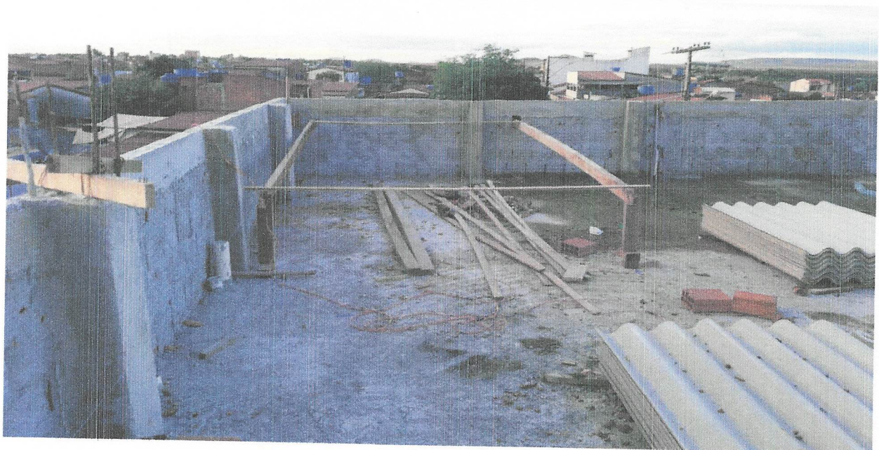
FOTO 49 - TRAMA DE MADEIRA COMPOSTA POR TERÇAS PARA TELHADOS DE ATÉ 2 ÁGUAS PARA TELHA ESTRUTURAL DE FIBROCIMENTO, INCLUSO TRANSPORTE VERTICAL. AF_07/2019
