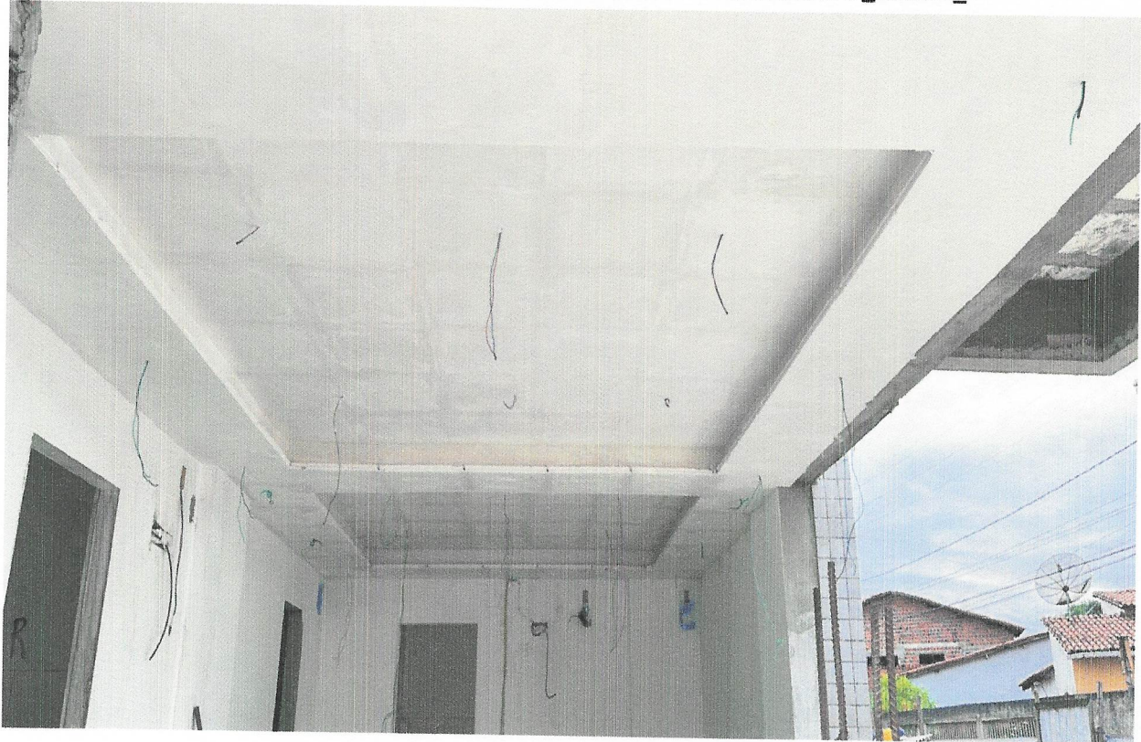
FOTO 31 - FORRO EM PLACAS DE GESSO, PARA AMBIENTES COMERCIAIS. AF_05/2017_P
