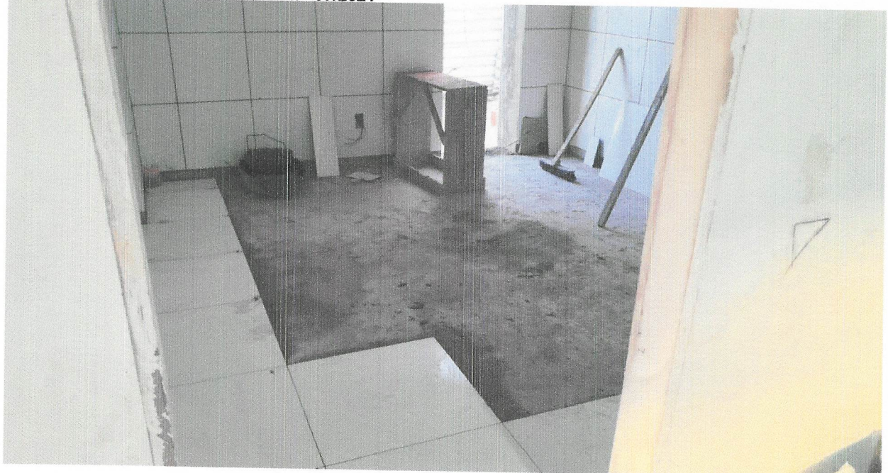
FOTO 22 - CONTRAPISO EM ARGAMASSA TRAÇO 1:4 (CIMENTO E AREIA), PREPARO MECÂNICO COM BETONEIRA 400 L, APLICADO EM ÁREAS SECAS SOBRE LAJE, ADERIDO, ACABAMENTO NÃO REFORÇADO, ESPESSURA 3CM. AF_07/2021
