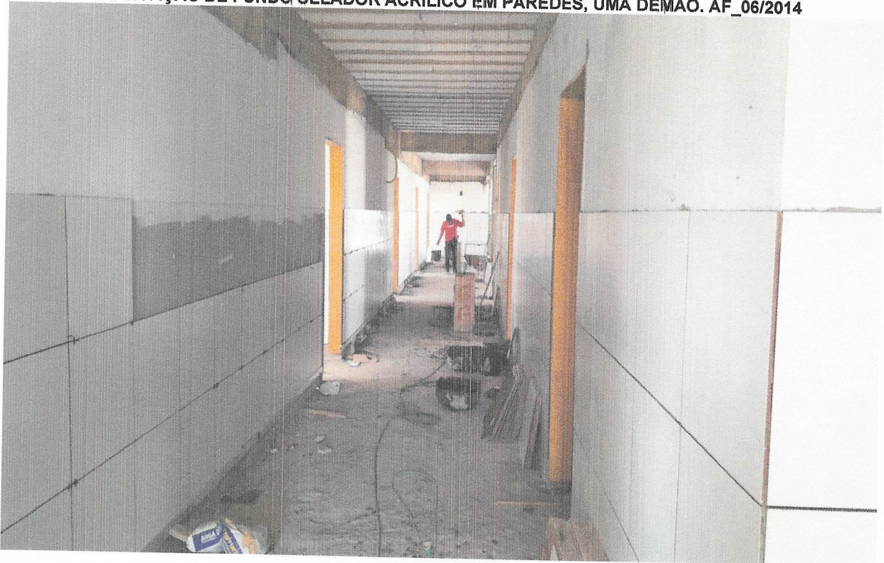
FOTO 35 - EMASSAMENTO COM MASSA A OLEO, DUAS DEMAS2014
