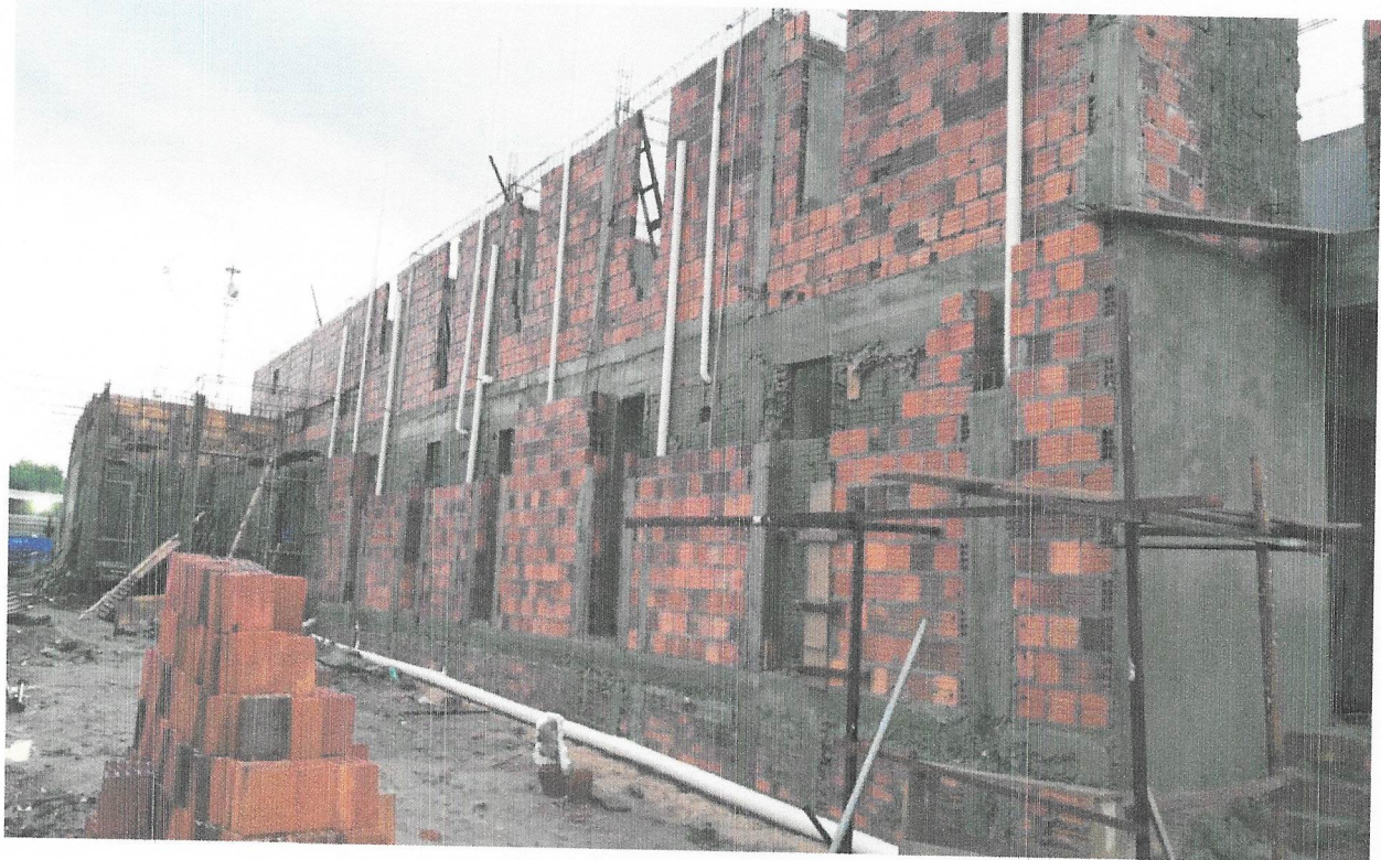
FOTO 77 – TUBO, PVC, SOLDÁVEL, DN 25MM, INSTALADO EM DRENO DE AR-CONDICIONADO - FORNECIMENTO E INSTALAÇÃO. AF_12/2014
